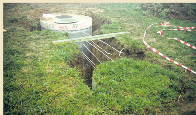
Abb. 2: Lysimeter und Messschacht, vor Fertigstellung der Anlage.
