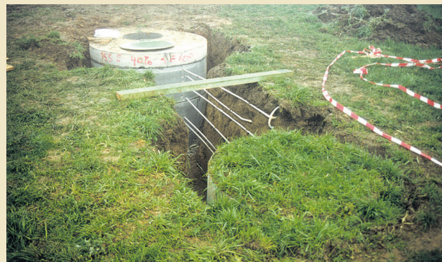
Abb. 2: Lysimeter und Messschacht, vor Fertigstellung der Anlage.
