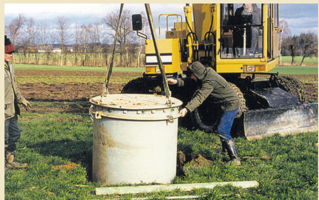
Abb. 1: Einbau des Lysimeters.
